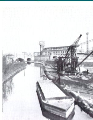
LE ARCATI FERROVIARIE DI GRECO 2
