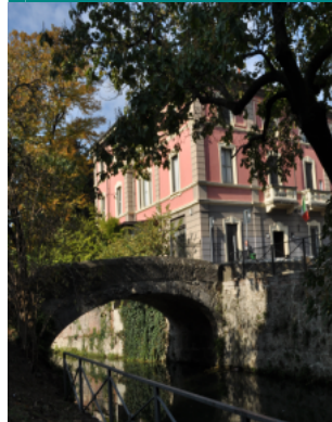
MUNICIPIO. PONTE VECCHIO 5
